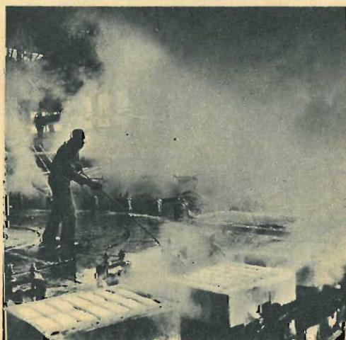
In alto: il minerale, in apposite vasche, viene sottoposto alla «percolazione» con opportuni reagenti. Qui sopra: la soluzione di sale di rame entra nei grandi apparecchi di elettrolisi.
